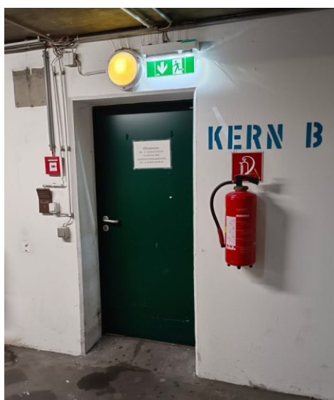
durch die Brandschutztüre
